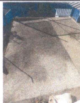
Foto 2: Colocación de torta de concreto en el patio frente los baños.
