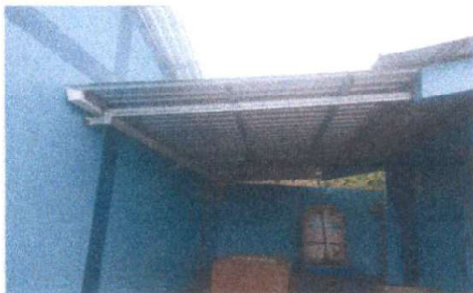
Foto 9: Instalacion de techo con estructura de metal sobre la pila.
