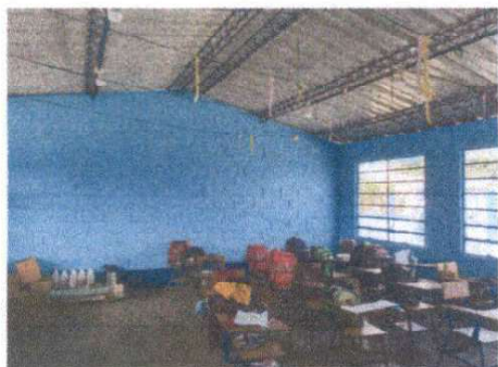
Foto 3: Pintura del interior de las aulas 1, 2, 3, 4, 5, 6, 7, 8, 9, 10.
