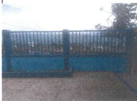
Foto 4: Intalación de baranda de metal en la pared en la entrada al centro educativo.
